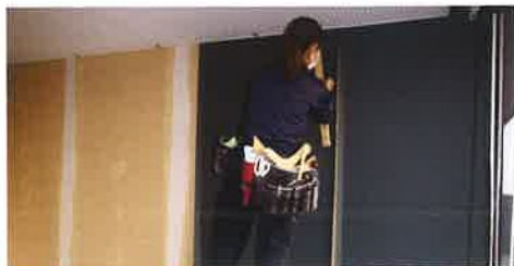
壁装職人による「クロス張り作業」
