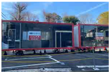
工場内で製造し、現場で組み立てるユニットハウス。全施工の7～8割が工場内で完成しているため、従来のプレハブ以上に短納期、なおかつ部材が進化しているため、居住性能も向上している。医療用検査施設など、これからの需要増が見込まれている。
